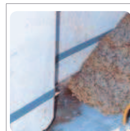
Eks. på tætning med Hydrotite® mellem det præfabrikerede tankelement og pladsstøbt beton.
